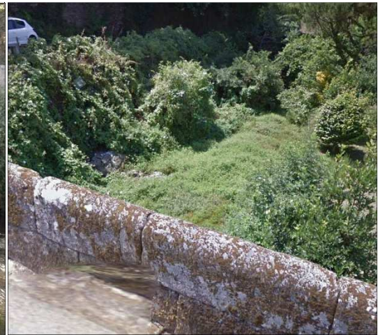
rio Sarela , uscendo da Santiago
